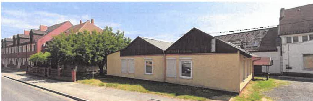
Tömb déli vége – hosszútávon átépítésre kerülő rész
