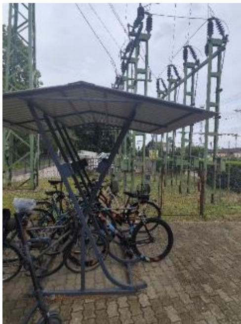
37. ábra Fedett kerékpártárolási lehetőségek a vasútállomásnál
