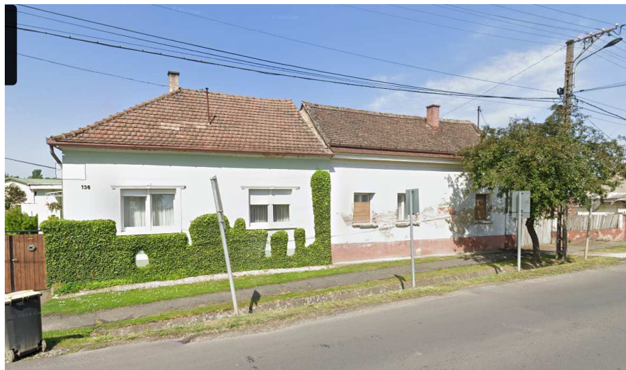
a 229 hrsz.-ú 138 számú, és a 231/1 hrsz.-ú 140 számú épület utcai nézete
